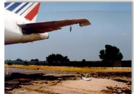
**3. En la superficie de las áreas de maniobras** se pueden ver afectadas debido a que no son diseñadas para soportar el chorro de aire de los motores de aeronaves, operando con alta potencia.
